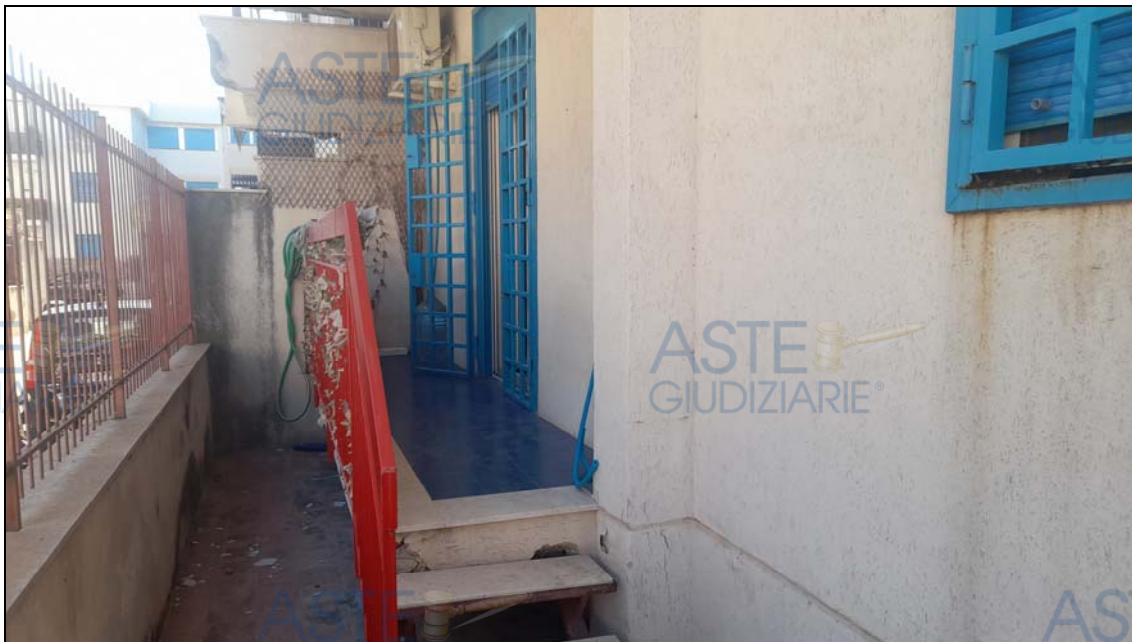
Foto N. 17: Balcone su villetta 2 (prospetto principale)
