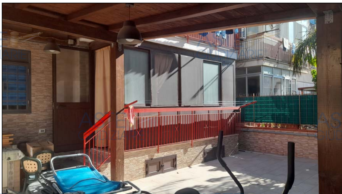
Foto N. 16: Veranda su villetta 1 (prospetto posteriore)
