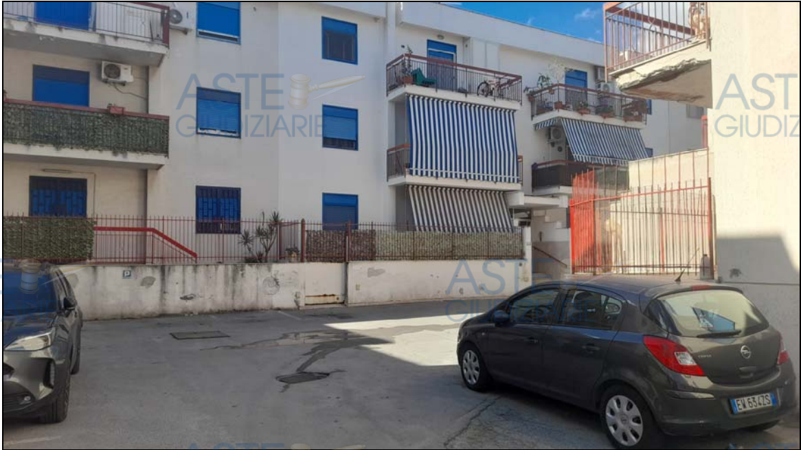
Foto N. 2: Stradella condominiale di accesso
