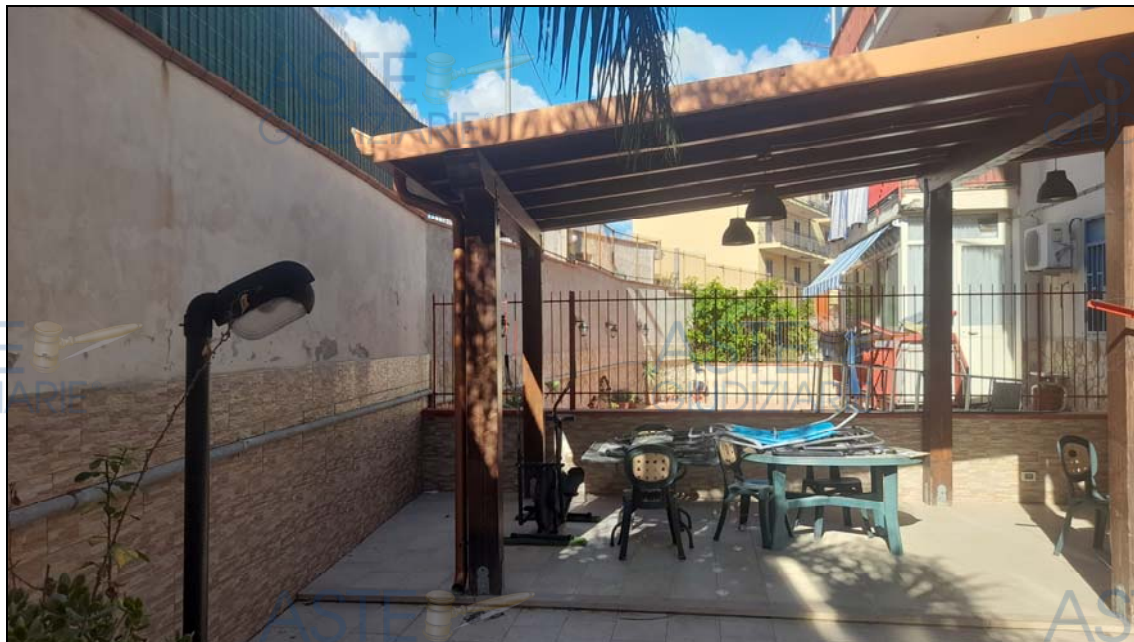
Foto N. 15: Tettoia su villetta 1 (prospetto posteriore)
