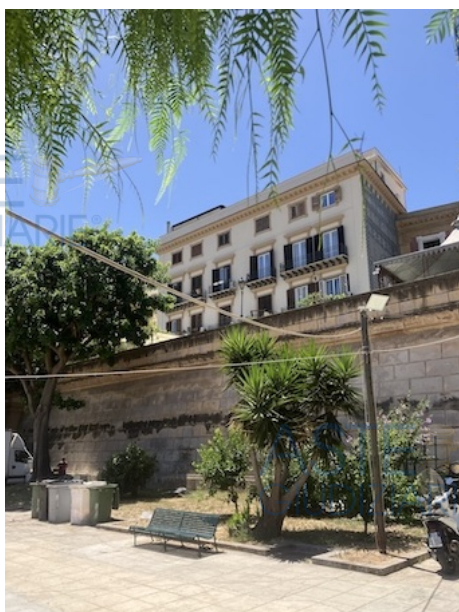
Foto n. 3 altra vista prospetto fabbricato
