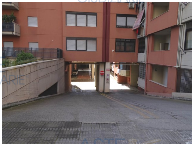
Rampa di accesso ai piani interrati (ed al posto auto 159)
