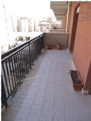
Balcone su prospetto principale
