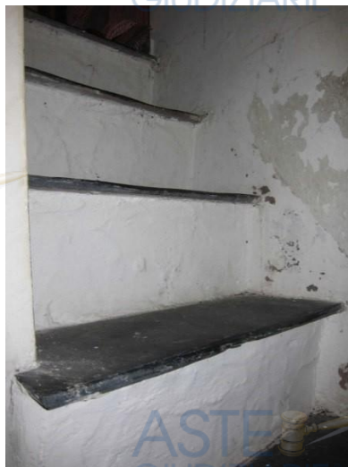
Scaletta di collegamento col soppalco
