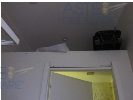
Soppalco porta oggetti del WC2
