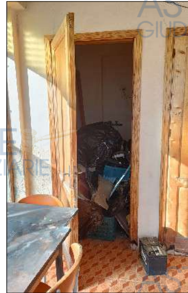
Vano di deposito
