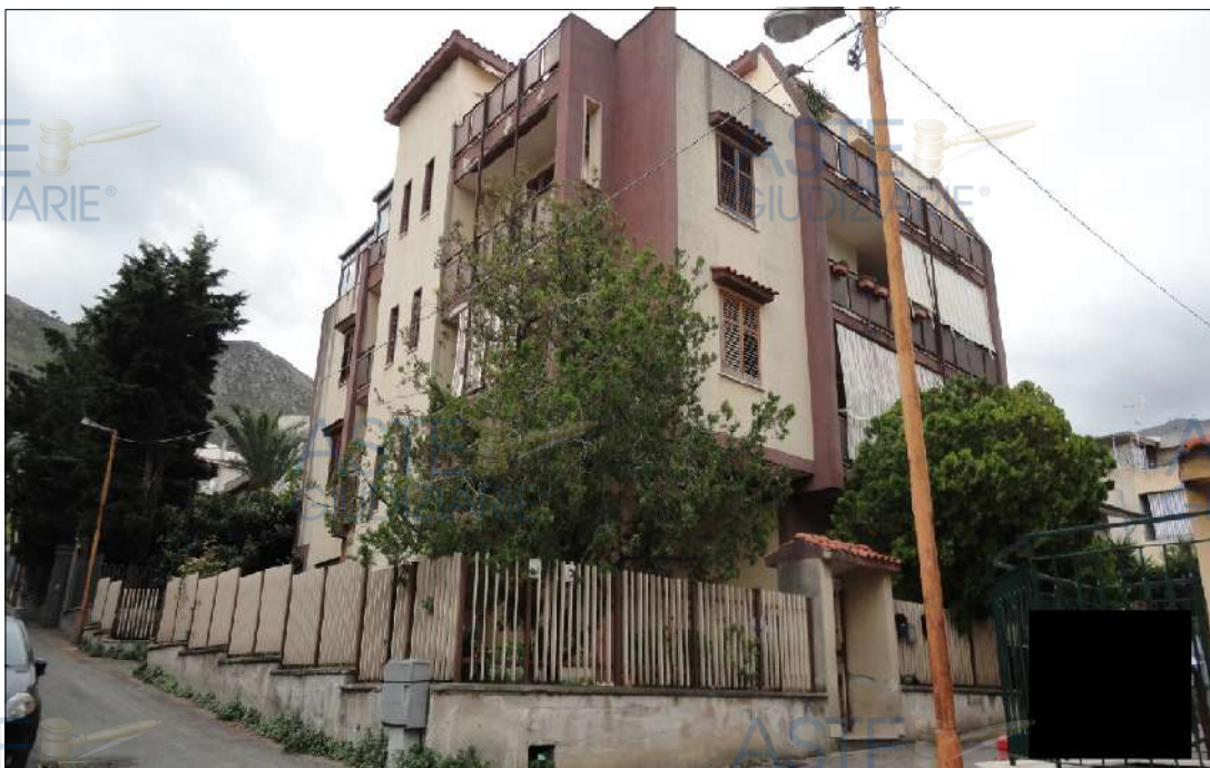
Veduta da via Cervino del fabbricato di cui fa parte l'immobile pignorato
