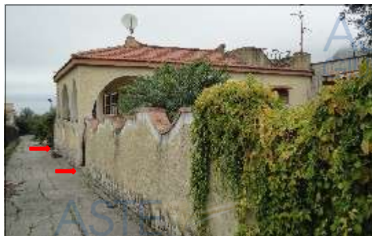
Accessi laterali dalla stradella privata
