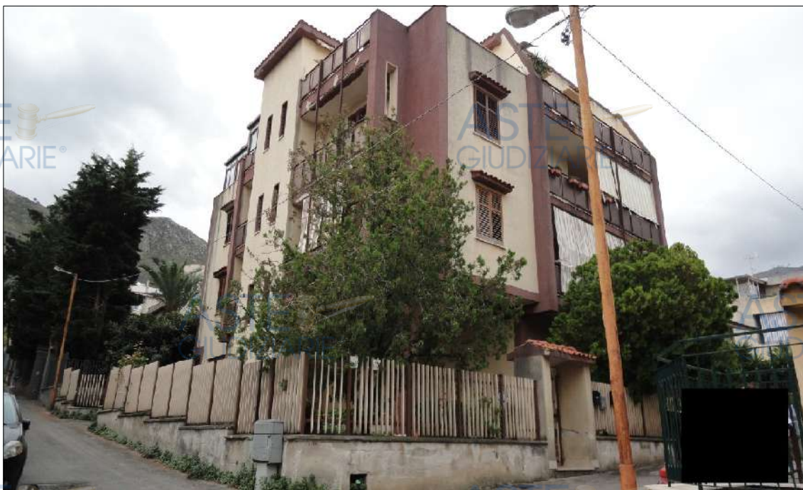
Veduta da via Cervino del fabbricato di cui fa parte l'immobile pignorato
