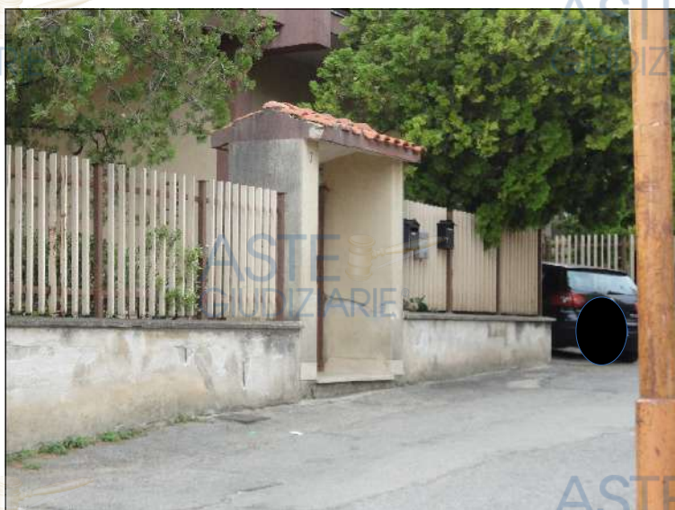
Accesso al fabbricato contraddistinto dal civ. 7
