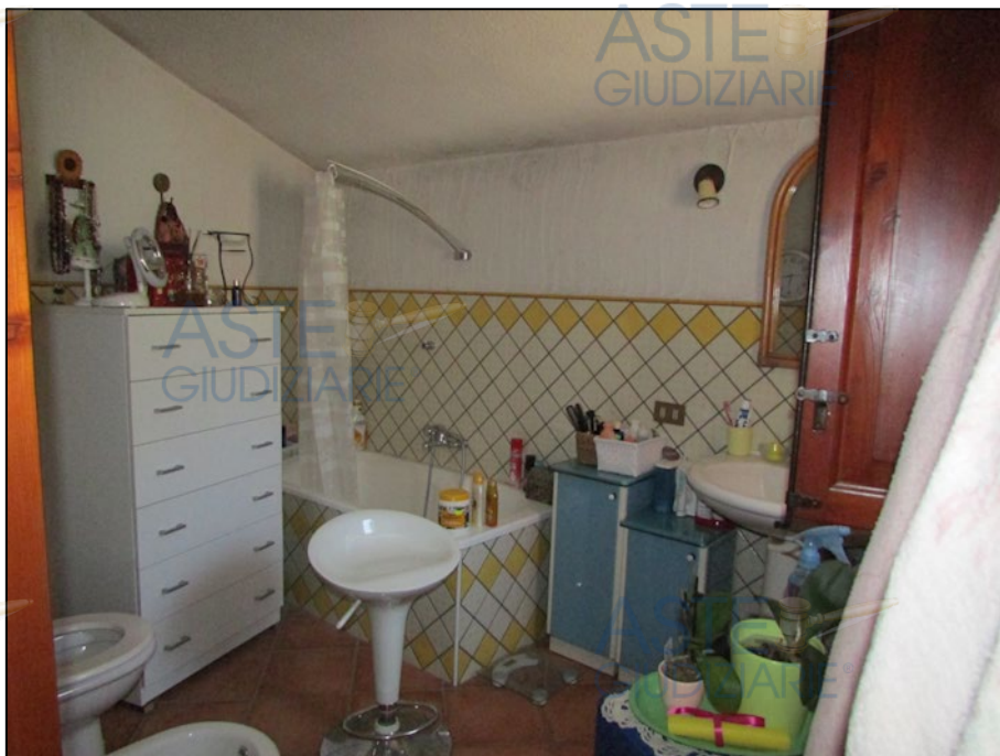
Figura 16: Particolare del servizio igienico "W.C. 2" al primo piano
