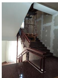
scala per il terrazzo di copertura
