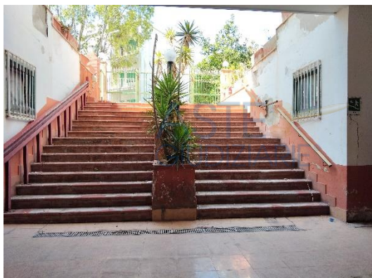
scala di accesso al piano cantinato
