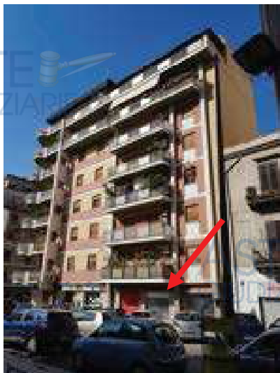
Foto n. 2 - Prospetto su Via Sampolo
