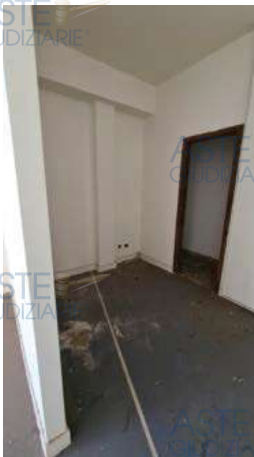
Foto n. 7 - Via Sampolo civ. 288 – interno locale commerciale – retro-negozio
