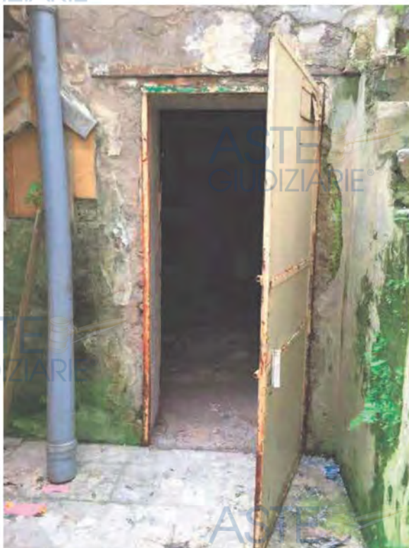
U.i. "B.3"- Ingresso dalla corte comune
