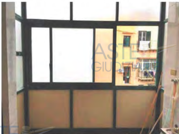
U.i. "B.2" - Veranda 2° piano (da dismettere)
