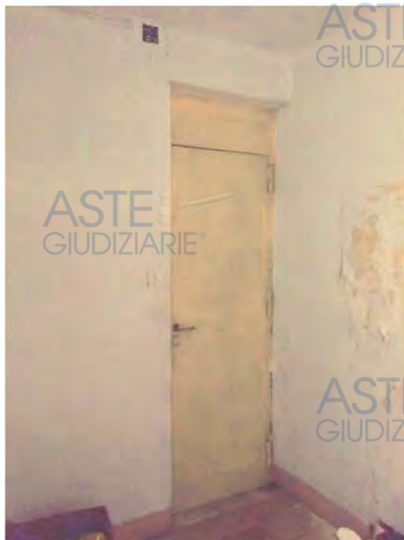
Ingresso immobile "A" dal vano scala
