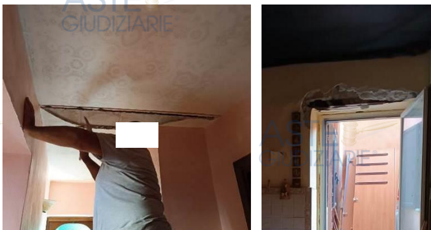
Figg. 30, 31 Picchiettatura e rimozione elementi, travi e architravi.
