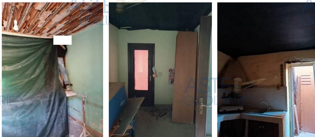
Figg. 32, 33, 34 Posa di rete anticaduta (ingresso/soggiorno, camera 1, cucina).
