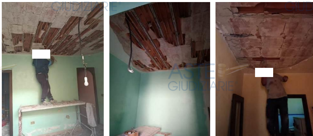
Figg. 27, 28, 29 Picchiettatura e rimozione elementi.
