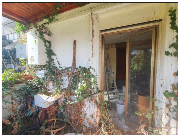
Foto 13– balcone di retroprospetto
