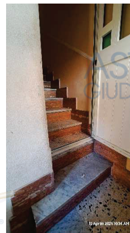
Rampa di accesso al 2° piano
