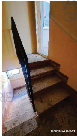
Rampa di arrivo al 3° piano
