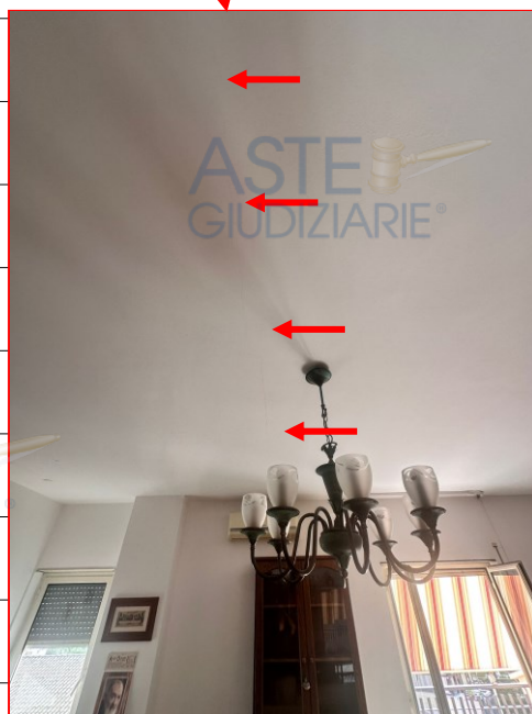
Cucina- A sinistra esfoliazione di intonaco sopra finestra, a destra lesione in direzione del travetto del solaio
