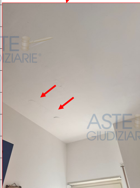
Cucina- A sinistra esfoliazione di intonaco sopra finestra, a destra lesione in direzione del travetto del solaio
