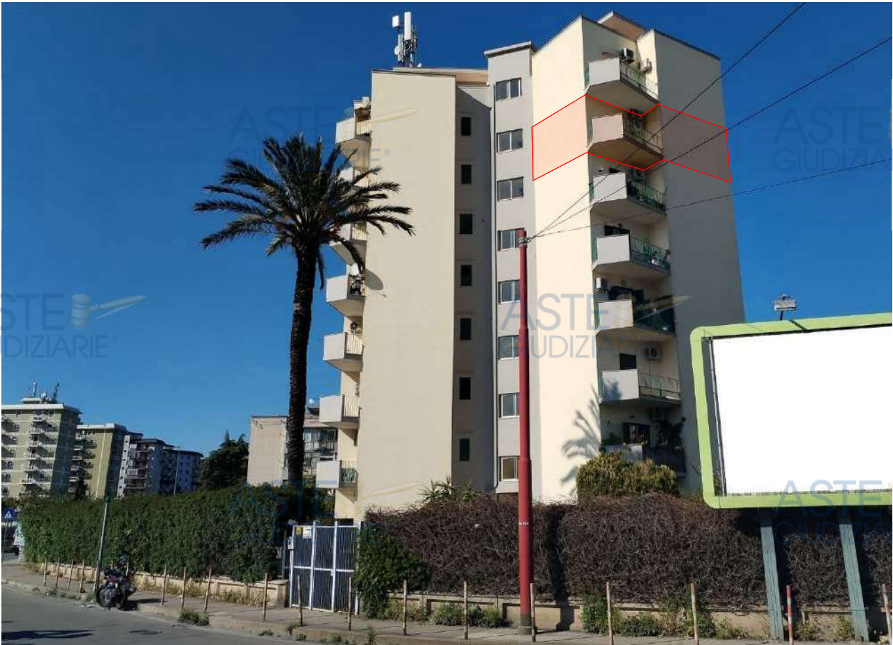
Visione del prospetto su viale della Regione Siciliana N.O. In rosso l'immobile oggetto di procedura
