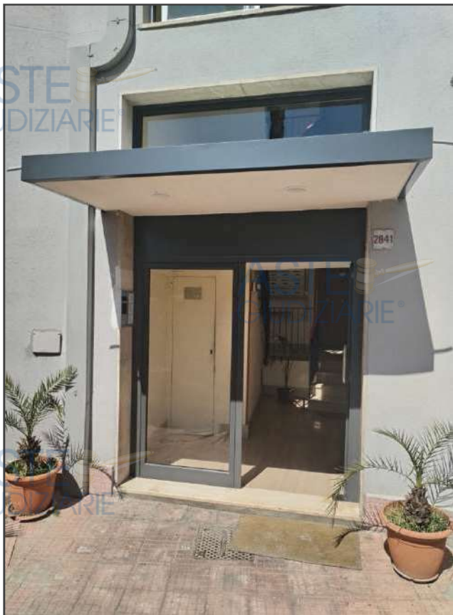
Ingresso diretto al fabbricato
