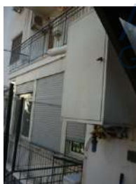
Foto 5 – Infissi esterni veranda
