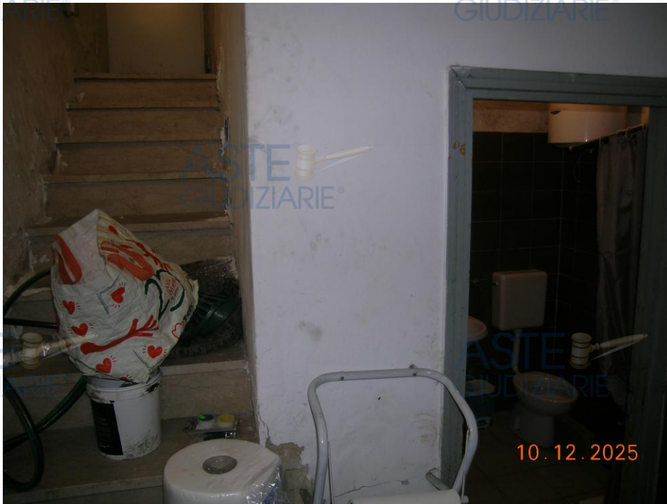
Foto 13 – Scala che conduce alla portineria dell'edificio avente accesso da viale Strasburgo 140
