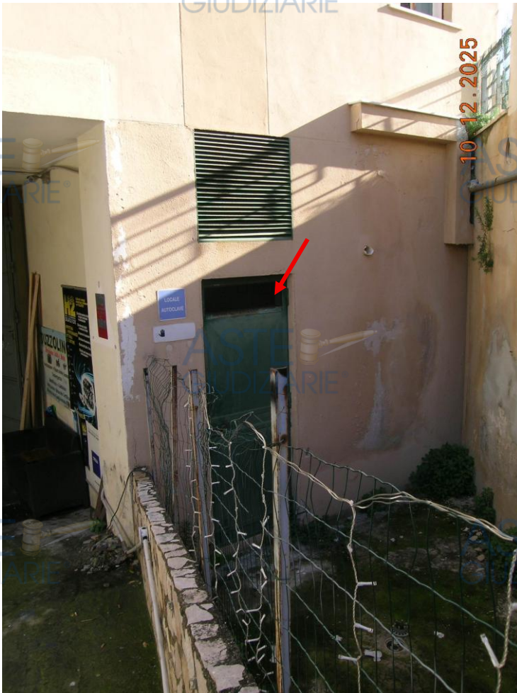
Foto 4 – La freccia indica il locale condominiale cisterna/autoclave
