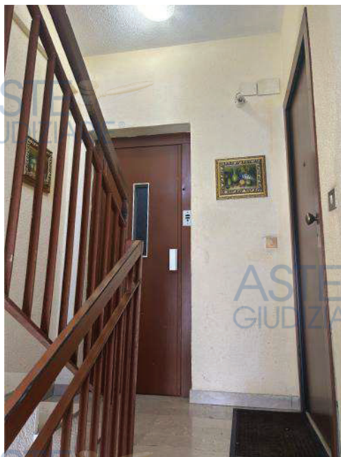
Foto n. 5 - Il pianerottolo con appartamento unico al piano
