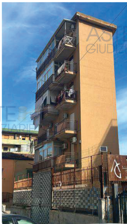
Foto n. 2 - L'edificio lateralmente (l'appartamento è al primo piano)
