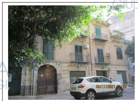
Foto 2. Portone di ingresso da via Pietro D'Asaro n. 22 al fabbricato che conduce agli immobili pignorati siti all'interno della corte condominiale
