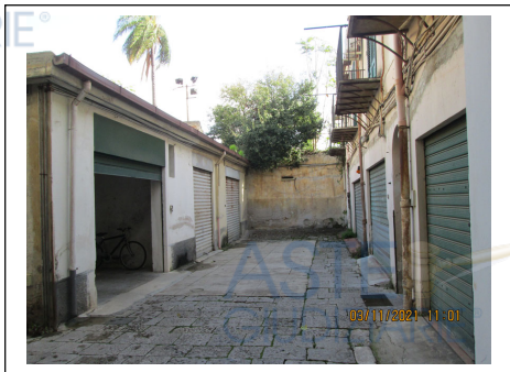
Foto 3. Corte interna dove si trova l'edificio ad una elevazione fuori terra di cui fa parte il bene pignorato. Ingresso da via D'Asaro n. 22.
