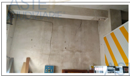
Foto 16. Interno del bene pignorato. Trave e pilastro adiacenti alla parete est
