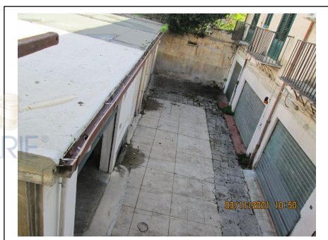
Foto 9. Fabbricato ad un livello fuori terra di cui fa parte il bene pignorato
