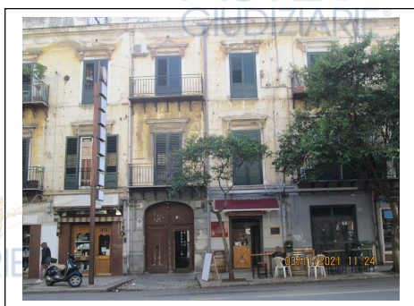
Foto 1. Portone di ingresso da via Dante n. 130 al fabbricato che conduce agli immobili pignorati siti all'interno della corte condominiale
