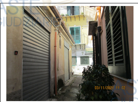
Foto 6. Passaggio comune che collega gli ingressi da via Dante n. 130 e da via D'Asaro n. 22.
