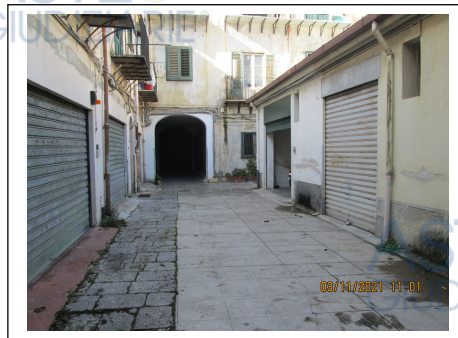
Foto 4. Corte interna dove si trova l'edificio ad una elevazione fuori terra di cui fa parte il bene pignorato. Ingresso da via D'Asaro n. 22.
