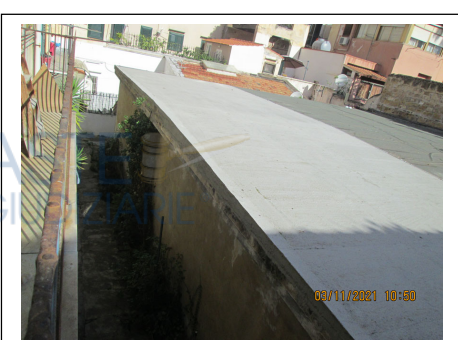
Foto 10. Fabbricato ad un livello fuori terra di cui fa parte il bene pignorato
