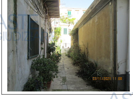
Foto 8. Passaggio comune che collega gli ingressi da via Dante n. 130 e da via D'Asaro n. 22.
