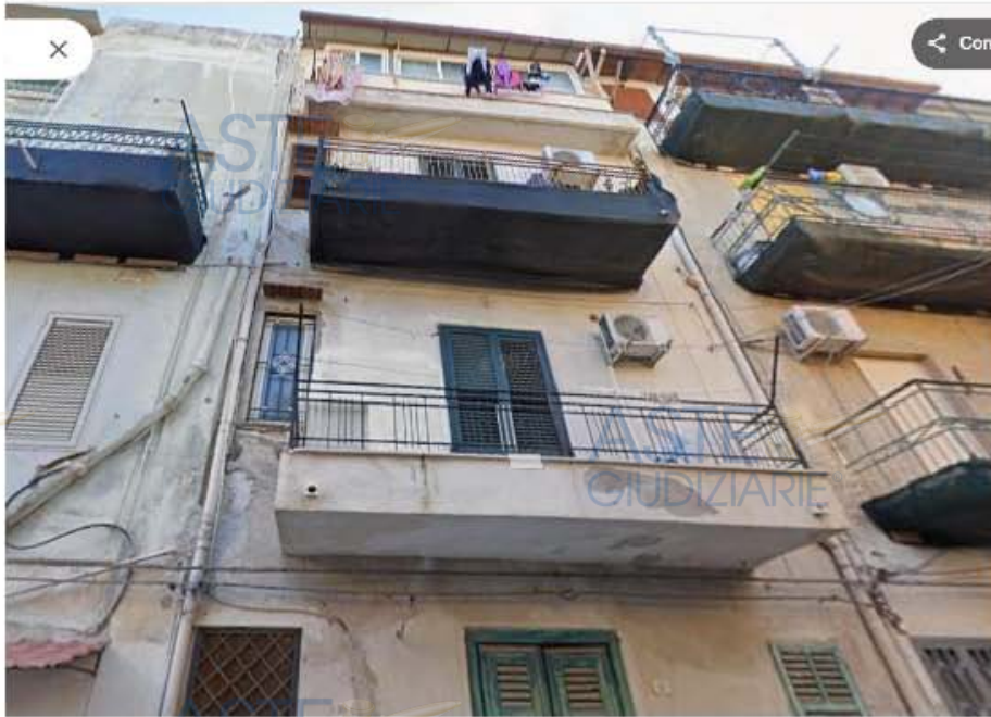
Foto 2: facciata della palazzina
