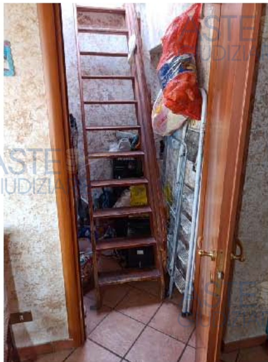
Foto 19: vano con scala verso la copertura lignea
