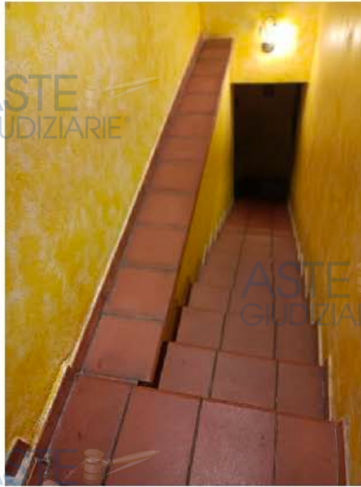
Foto 14: scala interna all'appartamento dal secondo al terzo piano
