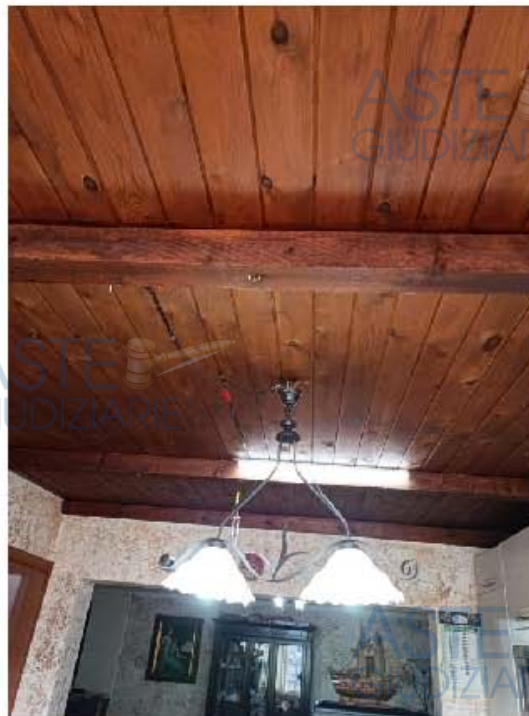
Foto 17: copertua lignea della porzione chiusa a veranda al terzo piano
