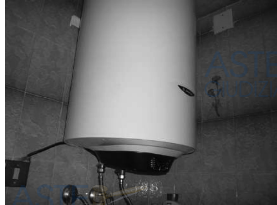
Foto 8 – Scaldacqua elettrico
