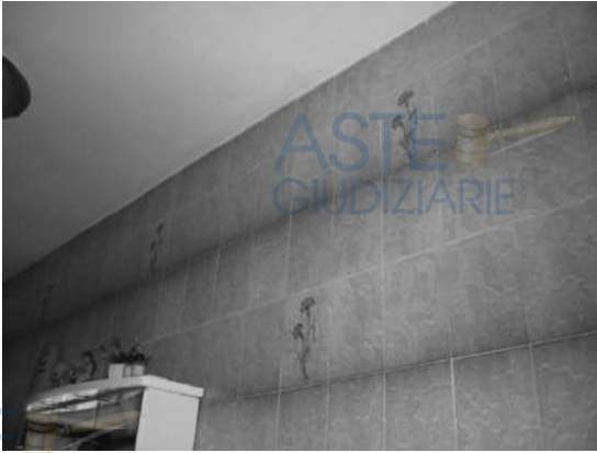
Foto 7 – Rivestimento servizio igienico
