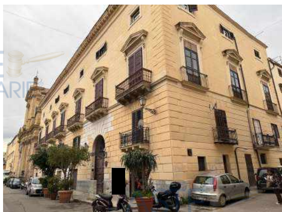
Foto n. 1 – prospetto su via Torremuzza
