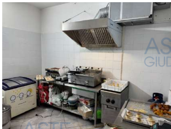
Foto n. 6 – retrobottega (cucina) sub. 72
