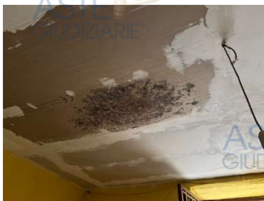
Foto n. 10 – estradosso soffitto sub. 73
