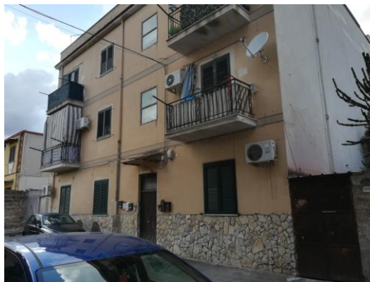
FOTO 3 FRONTE DELL'EDIFICIO SU VIA MARGIFARACI
