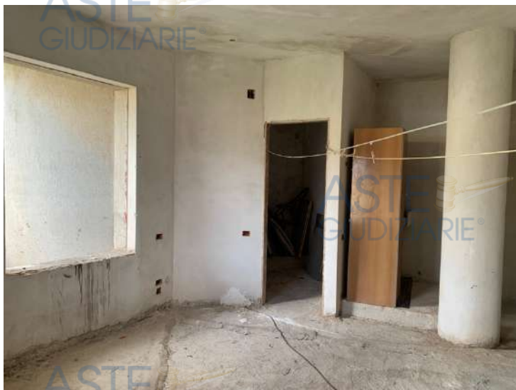
Foto n. 7 – Interno villa: piano primo incompleto
