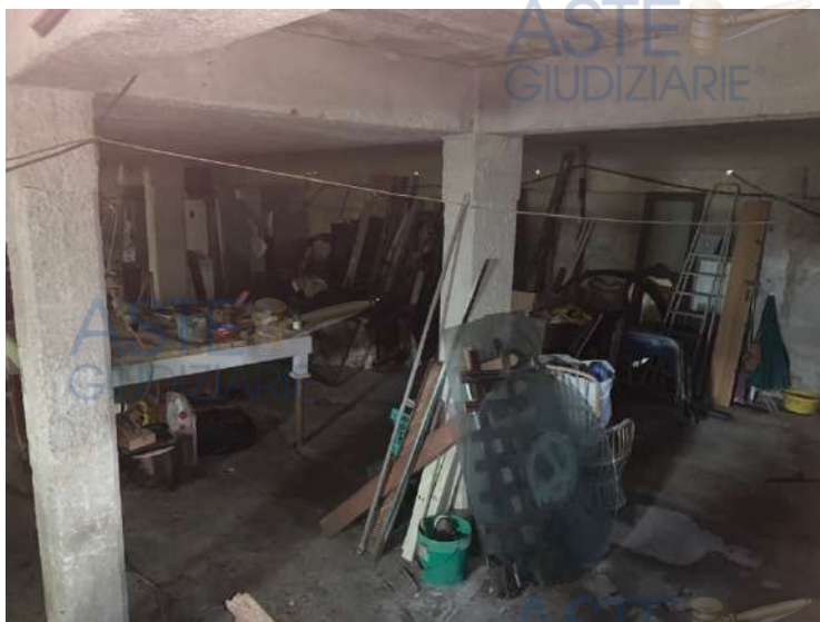
Foto n. 8 – Interno villa: piano seminterrato incompleto
