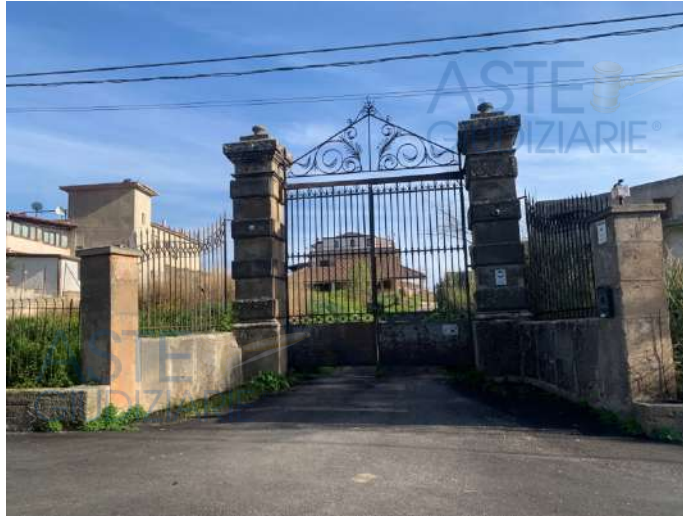
Foto n. 1 – Ingresso su via Valanche
