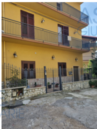
prospetto su via L. Pirandello
