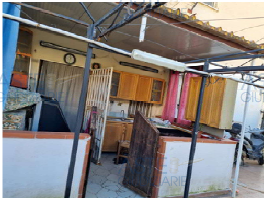
muro di 90 cm realizzato ex novo _ area esterna
