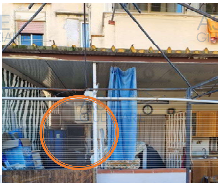
tramezzi realizzati ex novo_ balcone prospetto ovest
