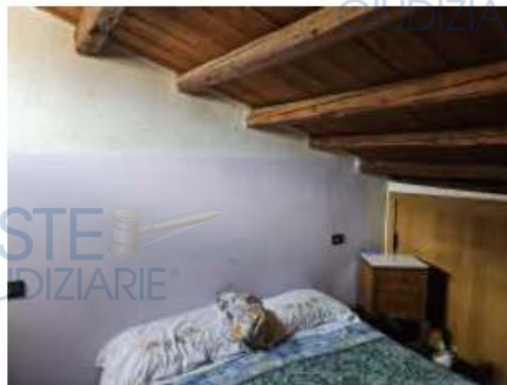
Foto n. 17 tetto del soppalco
