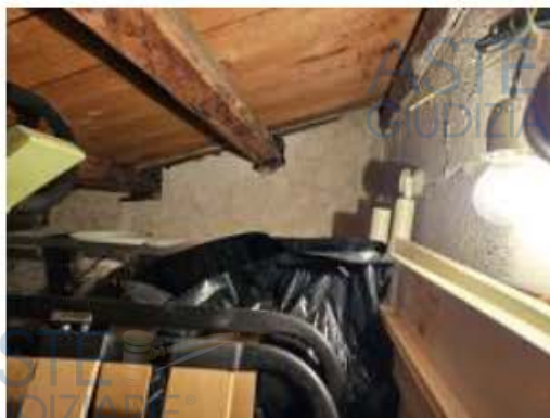
Foto n. 18 locale di sgombero realizzato nel sottotetto
