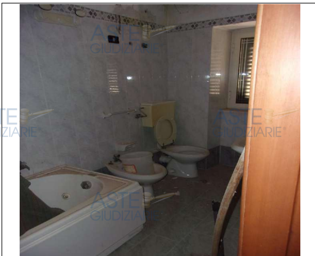
bagno al superiore ammezzato-primi piano
