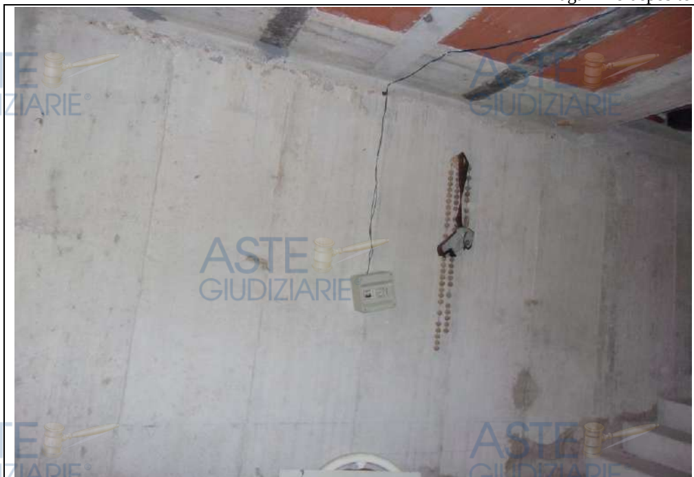
piano terra magazzino deposito
