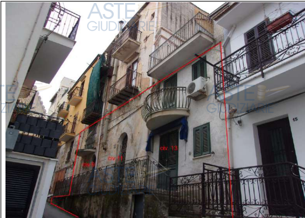
prospetto dell'intero immobile su Via Ludovico Ariosto
