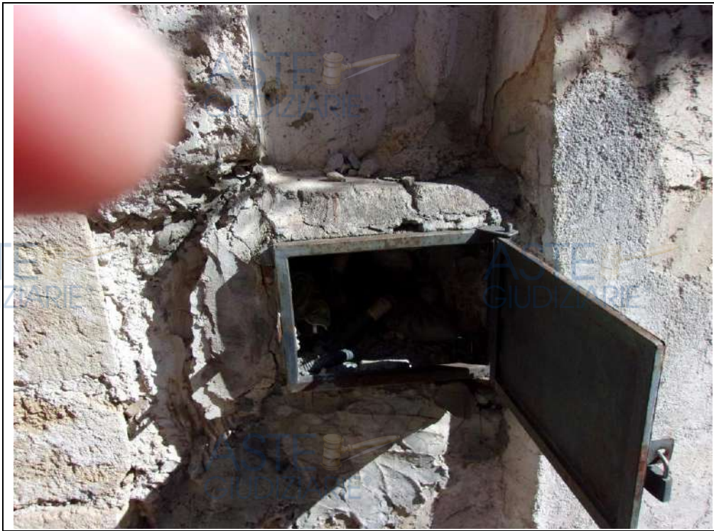
predisposizione contatore idrico
