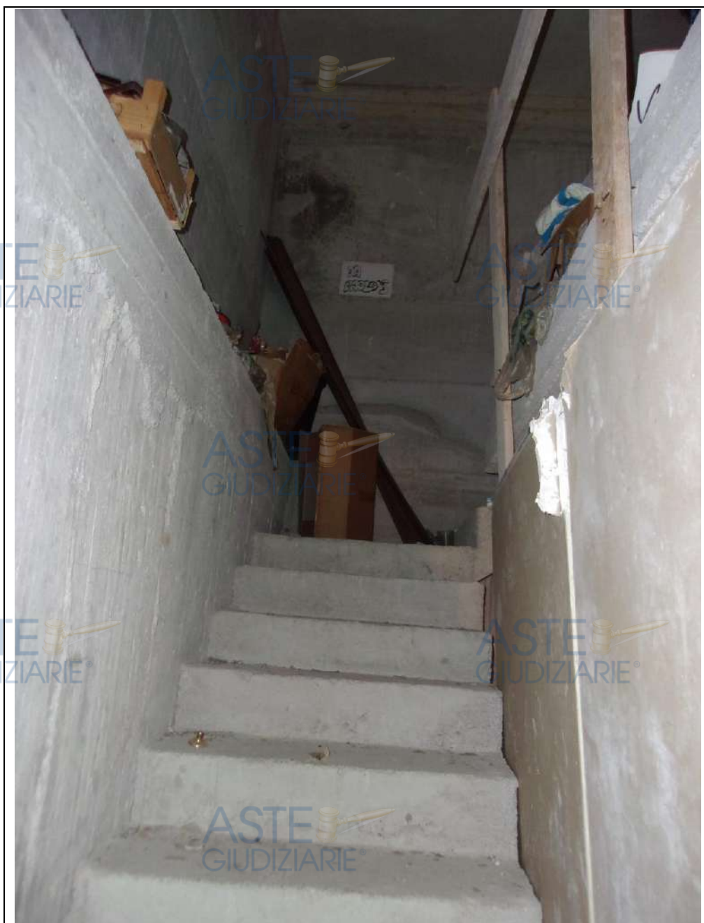
scala di accesso al piano superiore
