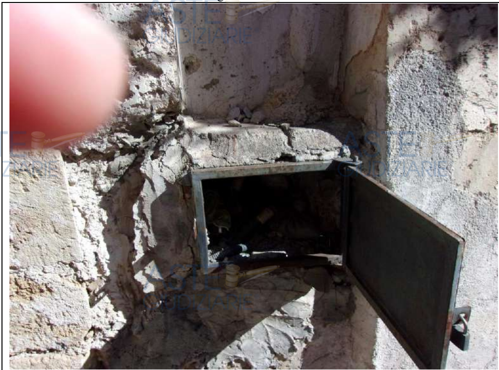
predisposizione contatore idrico
