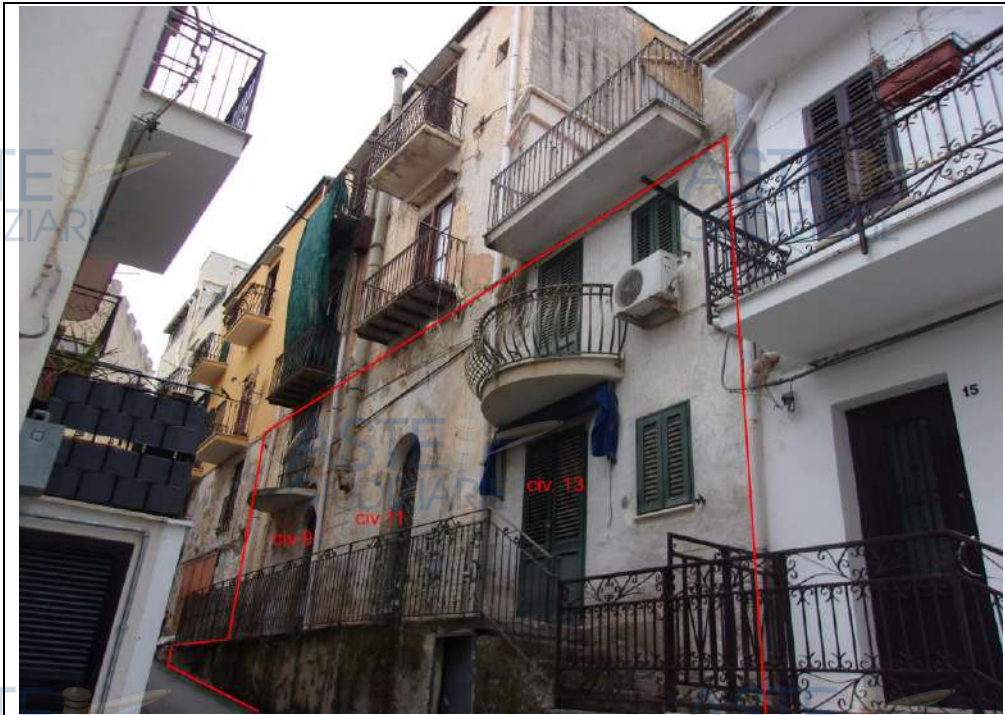
prospetto dell'intero immobile su Via Ludovico Ariosto
