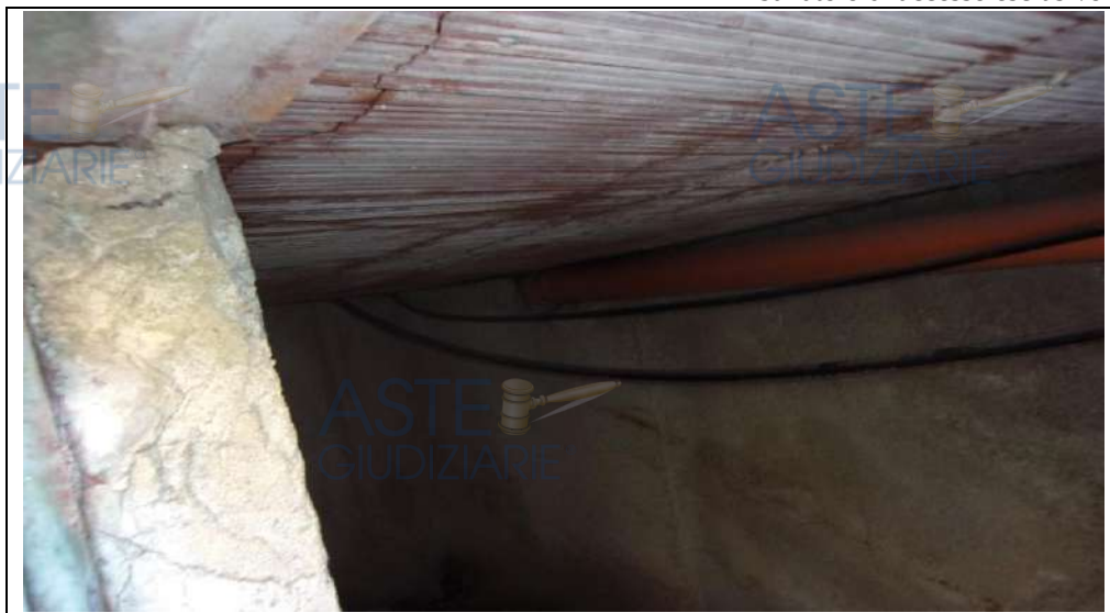
interno del ballatoio esclusivo di accesso in cui passano gli scarichi dell'immobile e le linee di allaccio idrico
