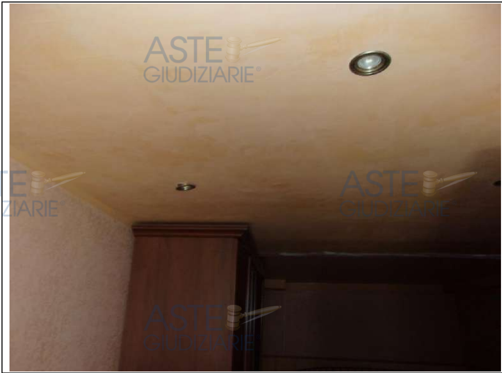
Camera da letto controsoffitto
