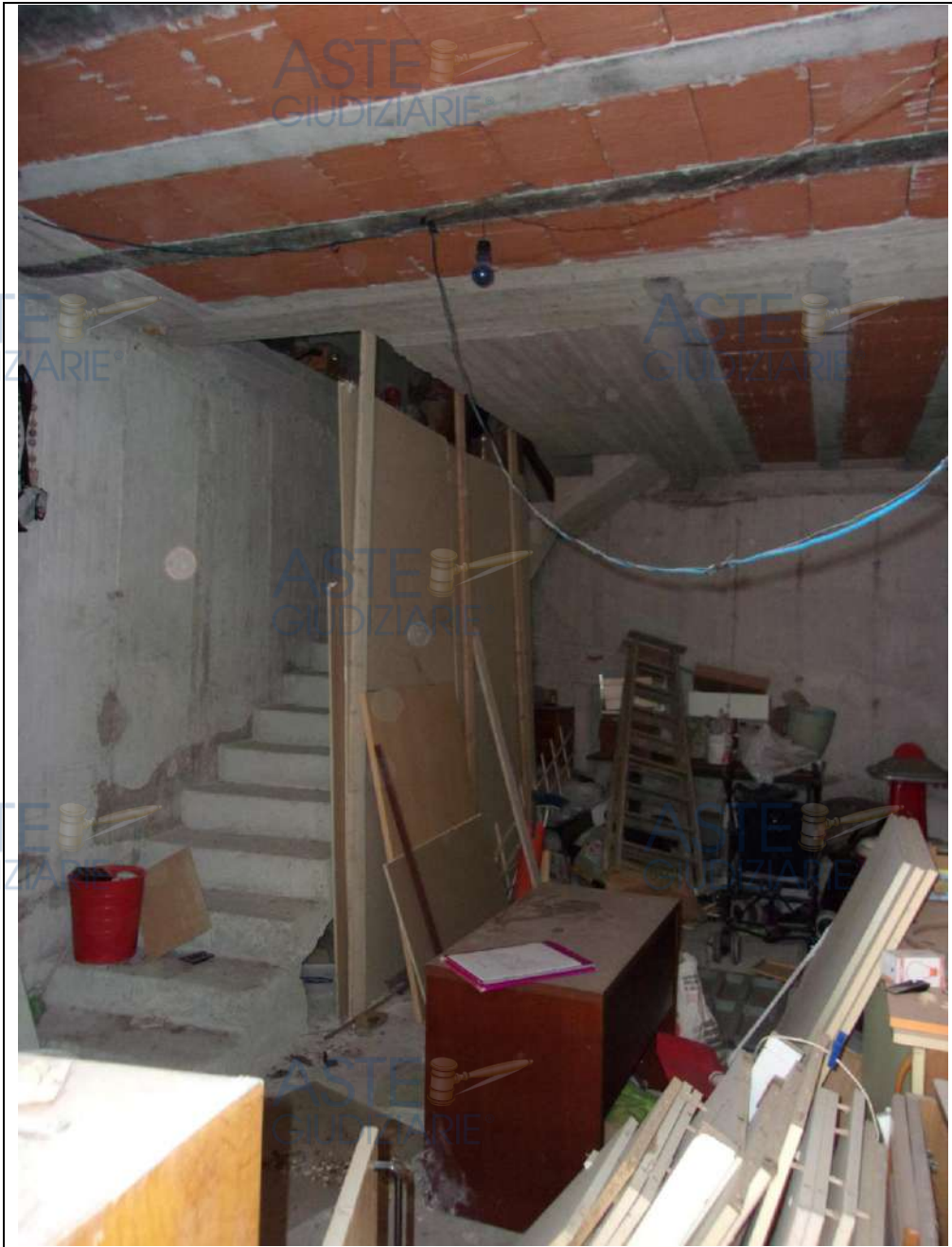
piano terra magazzino deposito
