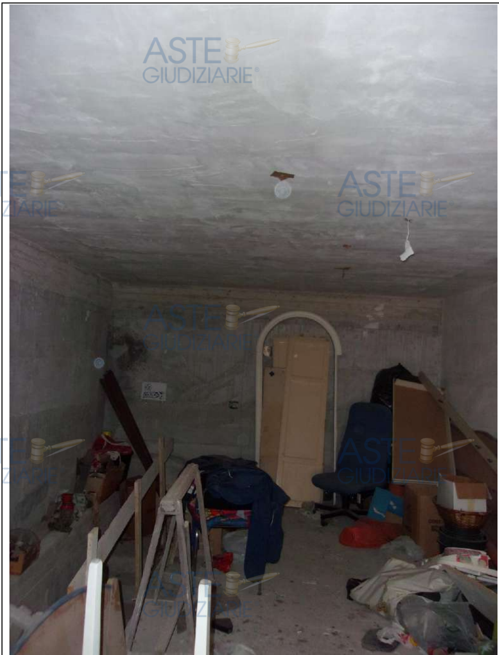
al piano superiore deposito
