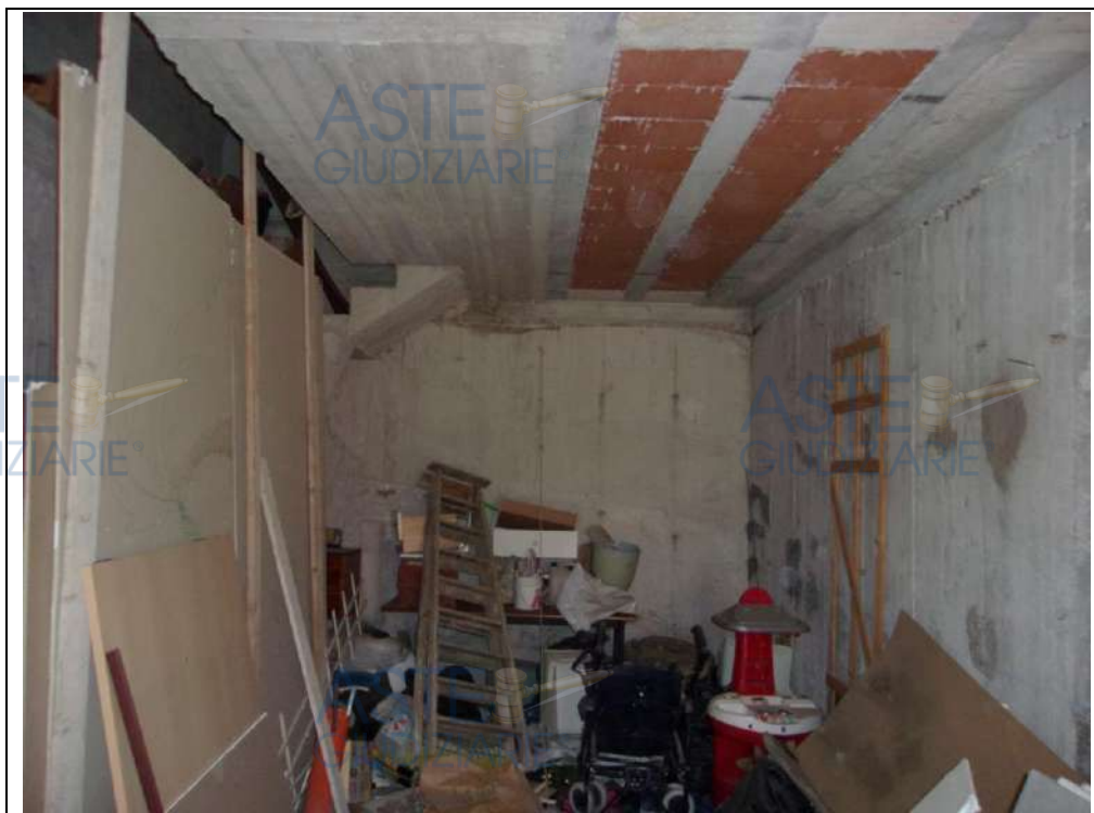
piano terra magazzino deposito
