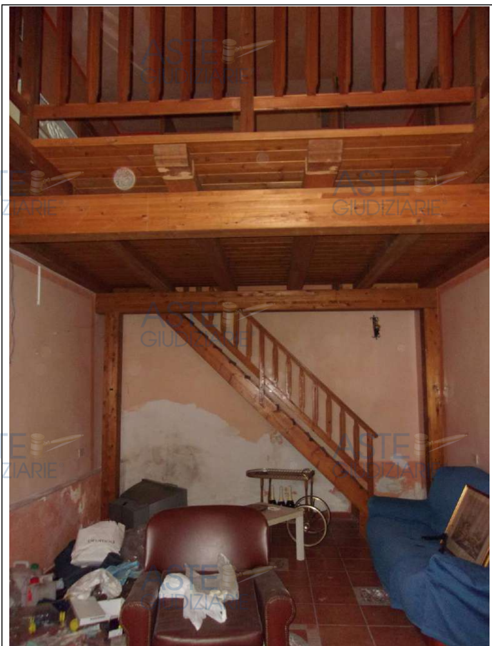
interno piano terra
