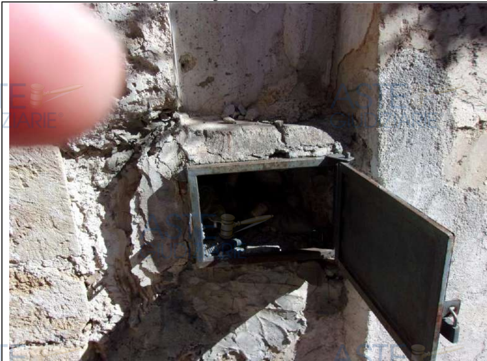
predisposizione contatore idrico
