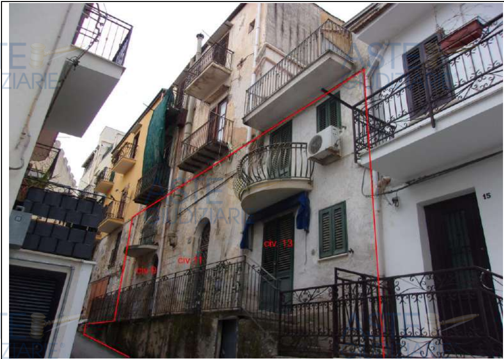
prospetto dell'intero immobile su Via Ludovico Ariosto
