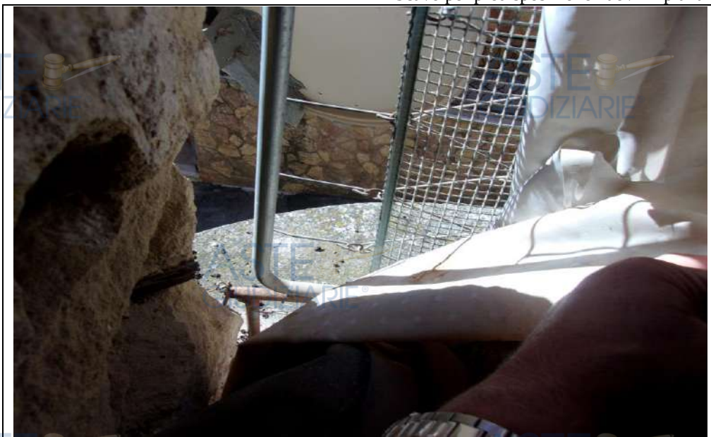
piano superiore deposito Balcone non accessibile ed al rustico
