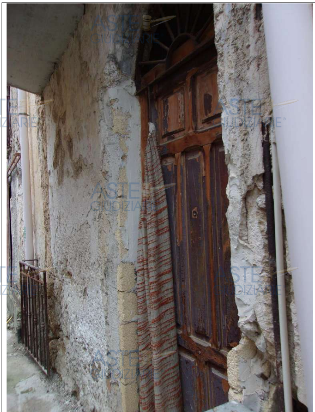
ingresso civico 9 magazzino deposito
