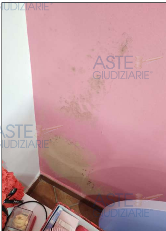
Camera da letto n.2. Muffa agli angoli e dietro i comodini, parete esterna rivolta a nord-est. Rif. 6 e 7 in planimetria.
