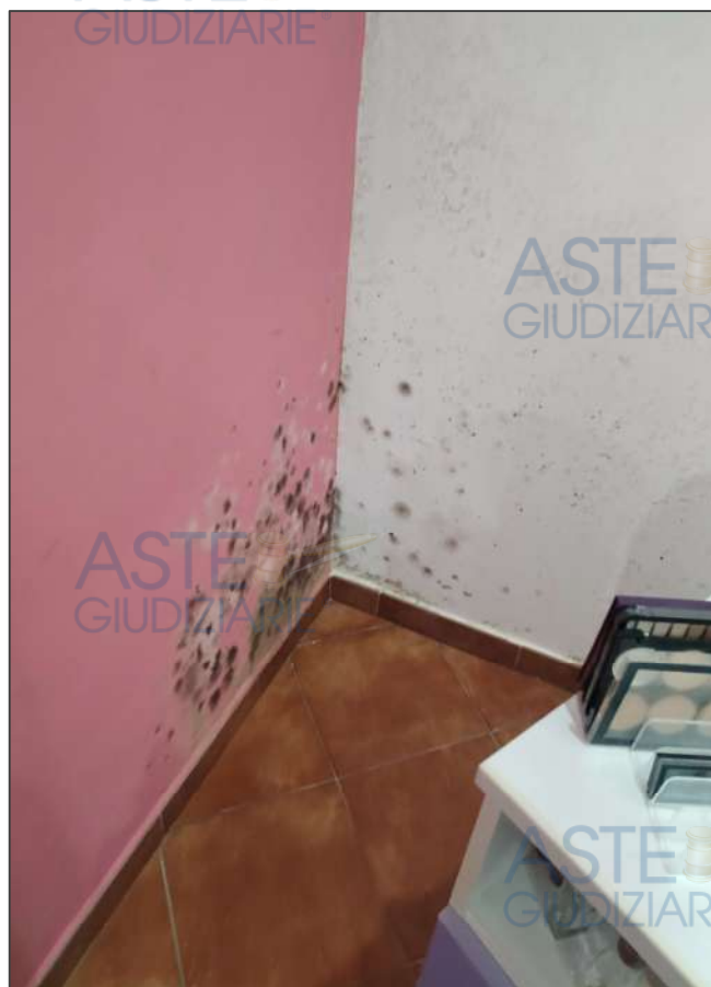
Camera da letto n.2. Muffa agli angoli e dietro i comodini, parete esterna rivolta a nord-est. Rif. 6 e 7 in planimetria.
