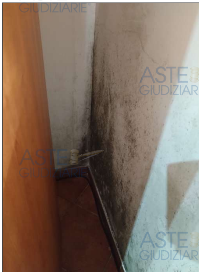
Camera da letto n.3. Muffa parete esterna lato sud-est, dietro mobili. Rif. 10 in planimetria.
