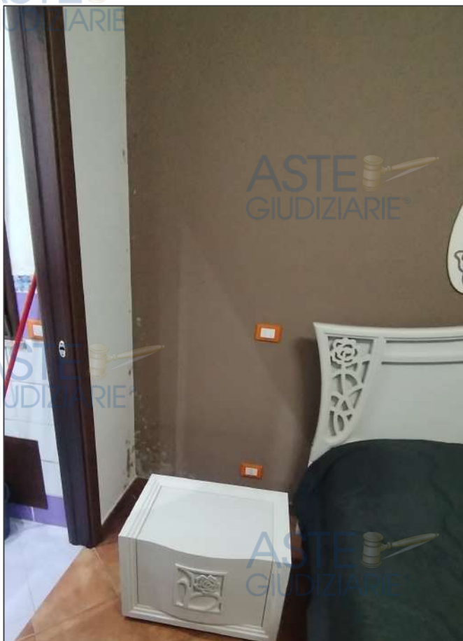
Camera da letto matrimoniale. Muffa agli angoli e dietro i comodini. Parete esterna lato nord-ovest. Rif. 1 e 2 in planimetria.
