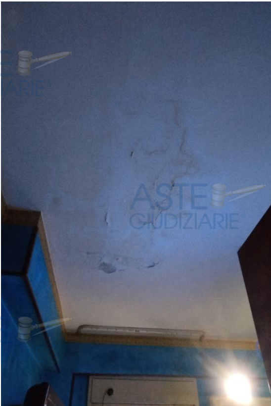
Danni da infiltrazione - camera da letto
