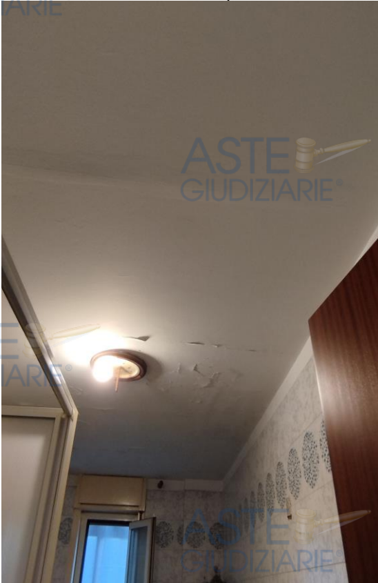
Danni da infiltrazione - bagno
