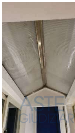
Foto n. 62 Copertura con struttura in acciaio e policarbonato alveolare
