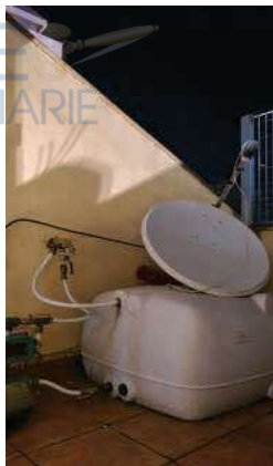
Foto nn. 78-80 - Terrazzo: Vasca di riserva idrica (dotata di pompa elettrica e pressostato) e caldaia
