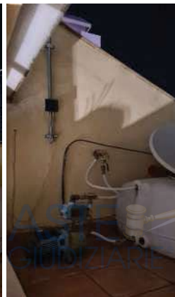
Foto nn. 78-80 - Terrazzo: Vasca di riserva idrica (dotata di pompa elettrica e pressostato) e caldaia
