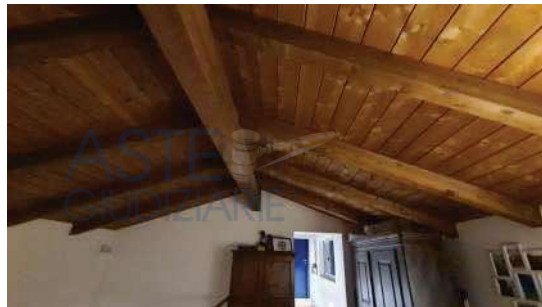
Foto 57 Studio - Copertura con struttura in legno
