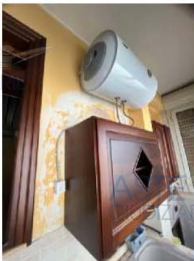
Veranda annessa alla cucina (senza infisso divisorio) Scaldabagno elettrico con vecchia infiltrazione di umidità
