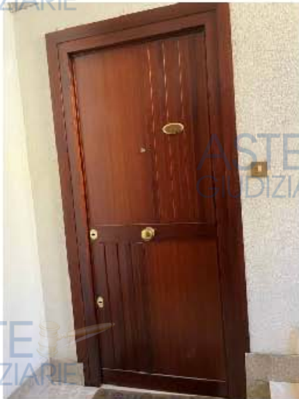
Porta di ingresso all'appartamento
