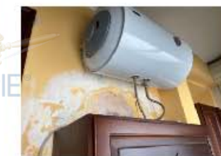
Veranda annessa alla cucina (senza infisso divisorio) Scaldabagno elettrico con vecchia infiltrazione di umidità
