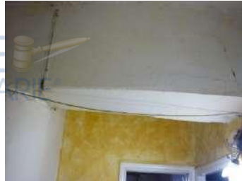
Foto 17 – Impianto elettrico fuori traccia
