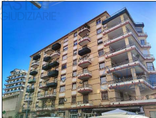
Edificio di via Armando Diaz n. 92
