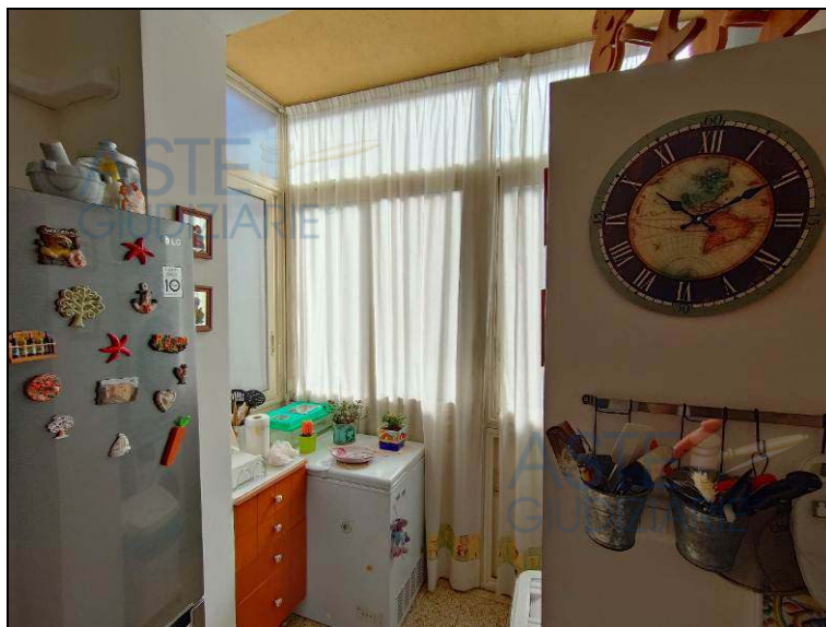
Veranda realizzata sul balcone posto in corrispondenza del retrospetto, con rimozione di infisso
