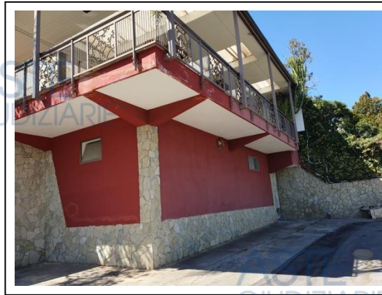
Foto n. 9 – vista esterna locale spogliatoio
