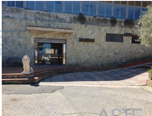
Foto n. 3 – vista del piano terra e ingresso locale bar
