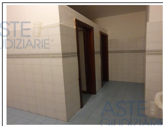
Foto n. 23 – servizi igienici di primo piano
