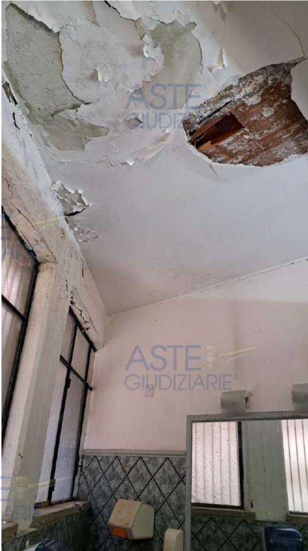
Foto 18 – wc (soffitto ammalorato)
