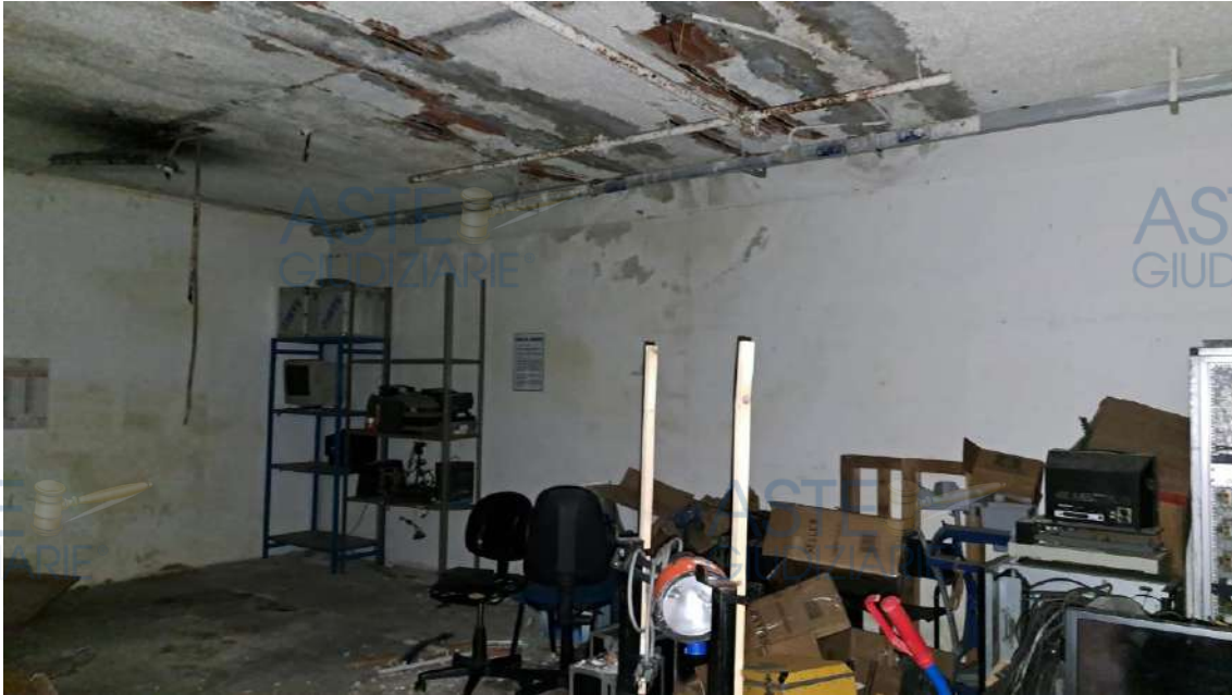
Foto 19 – deposito (soffitto ammalorato)
