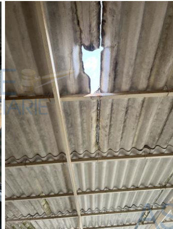
Foto 11-Particolare copertura ETERNIT
