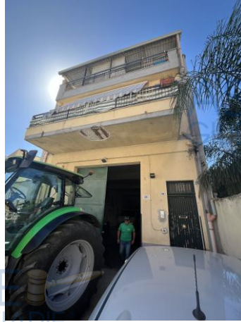
Foto 2-Vista esterna del fabbricato
