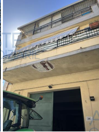
Foto 3-Vista esterna del fabbricato
