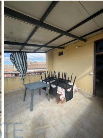
Foto 12-Terrazza con tettoia con ondulina
