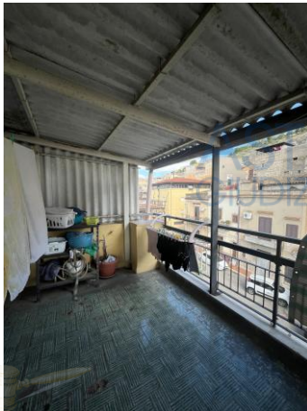
Foto 10-Terrazza con tettoia in ETERNIT
