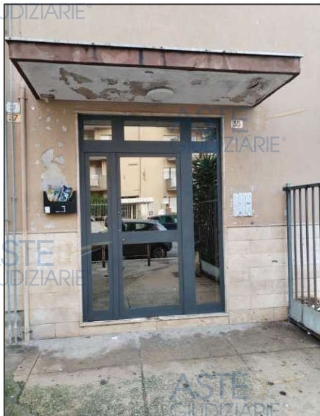
Portone di ingresso al fabbricato, via Luigi Galvani n.35
