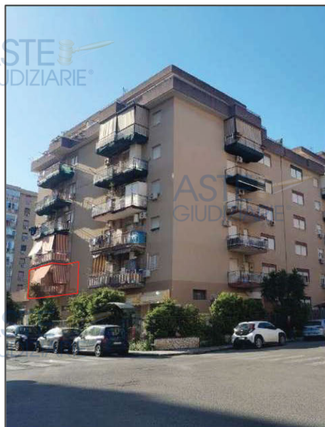
Visione angolare del complesso. In rosso l'immobile oggetto della procedura.
