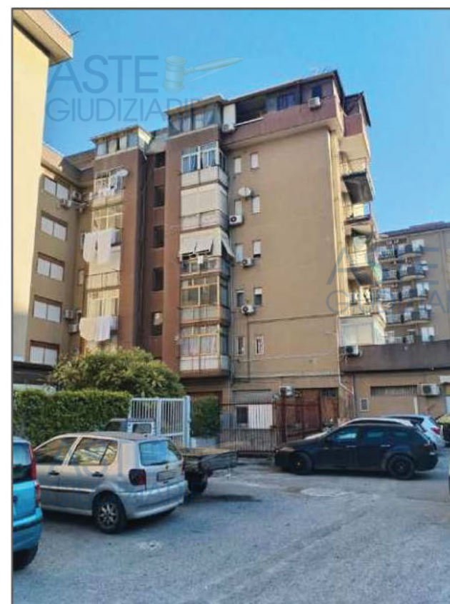
Retroprospetto su atrio interno.
