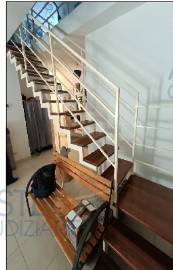
Foto 20 – Scala di accesso al sottotetto
