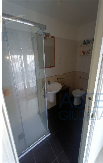
Foto 27 – Wc-doccia (loc. tecnico)
