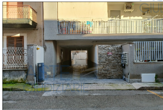
Foto 3 – Accesso al fabbricato civ. 5
