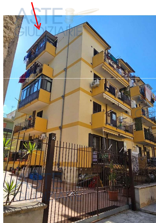
Foto. 4 vista del prospetto dalla corte
