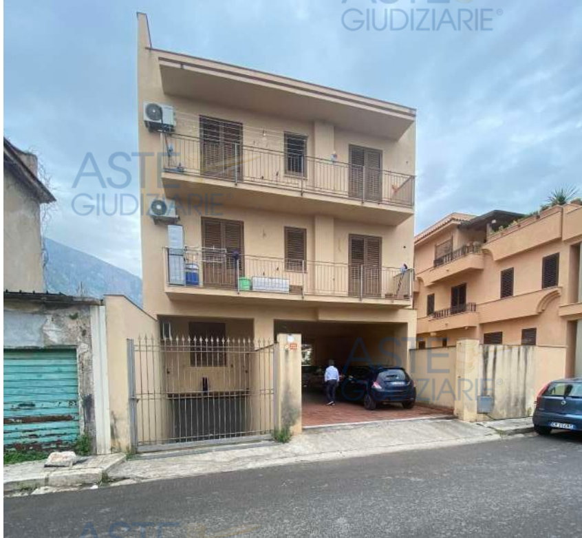
Vista dell'ingresso al condominio sito in via Guerrino Miglioranzì SNC
