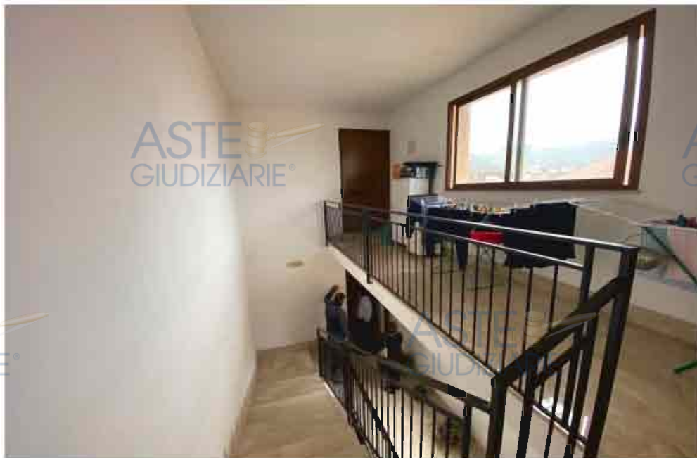
Figura 2.q – Accesso al lastrico solare
