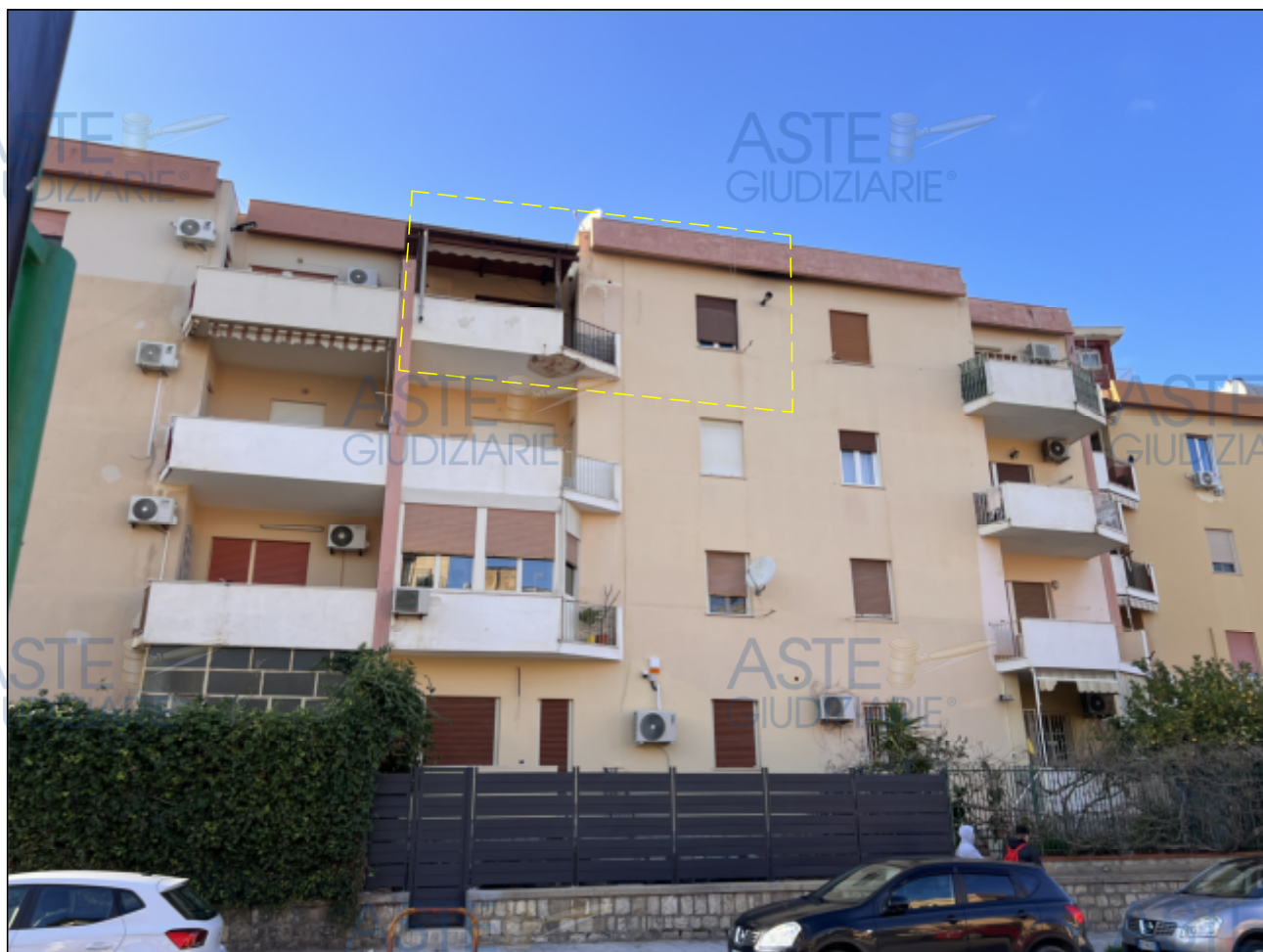
vista da viale Amedeo D'Aosta
