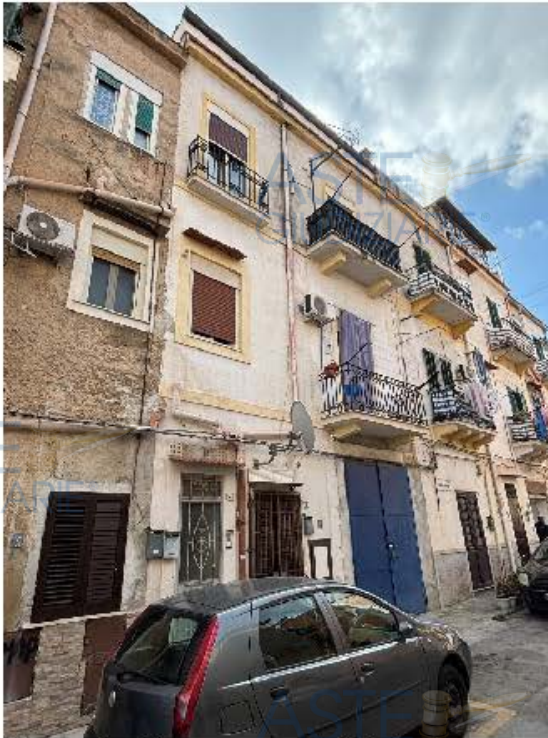
Foto n. 1 – Prospetto su via Mario Arezzo
