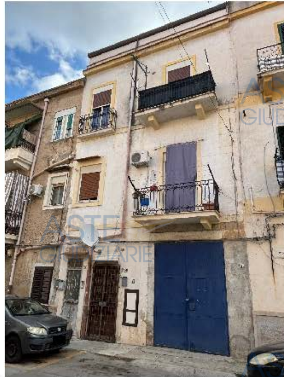
Foto n. 2 – Prospetto su via Mario Arezzo
