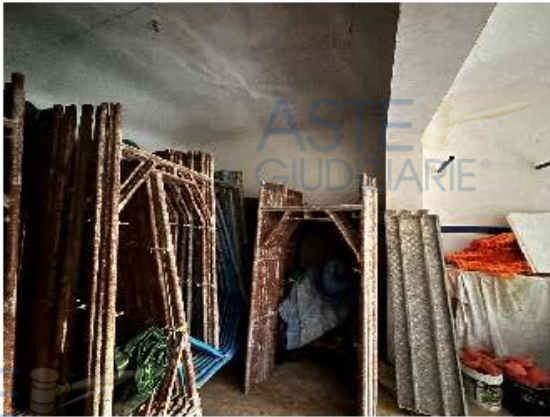
Foto n. 5 – Magazzino via M. Arezzo, 16/A
