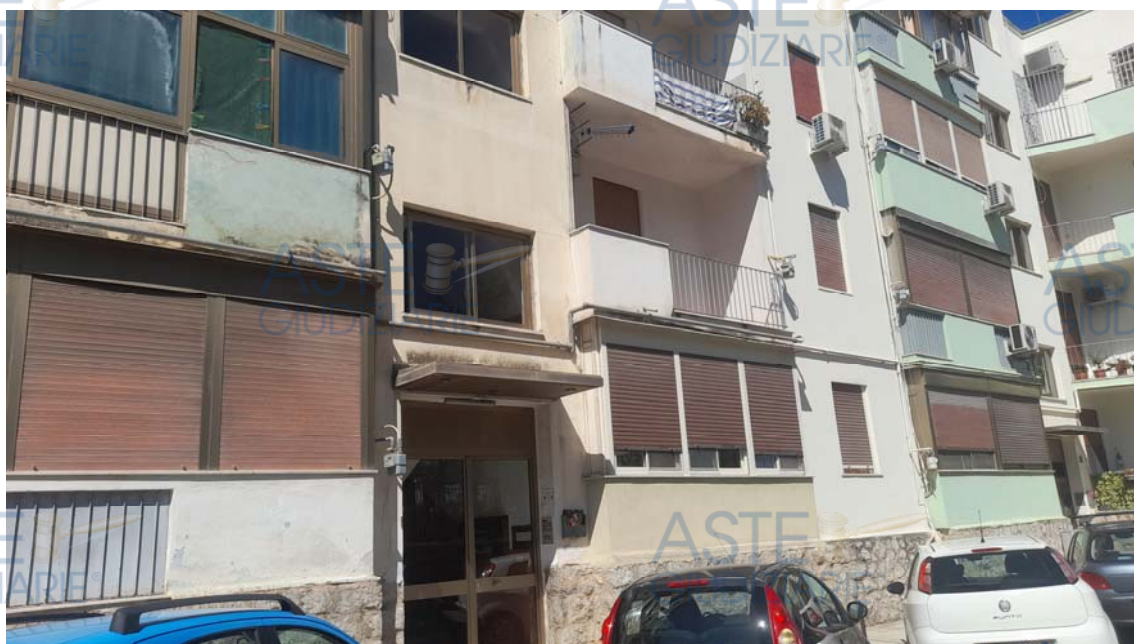
Foto N. 1: Portone d'ingresso al fabbricato di cui fa parte l'immobile (Scala E)
