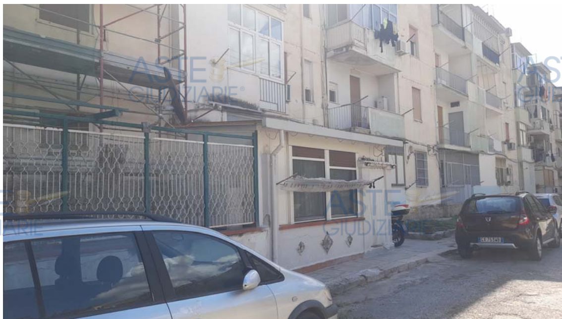
Foto N. 4: Corpo aggiunto realizzato sul retroprospetto
