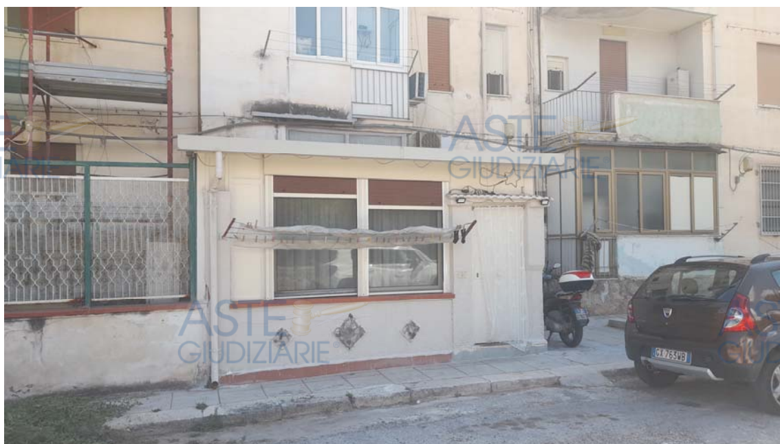
Foto N. 5: Corpo aggiunto realizzato sul retroprospetto
