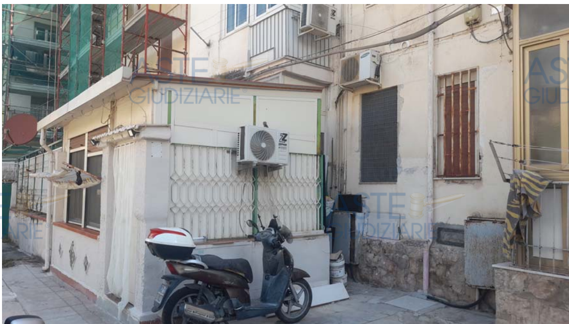
Foto N. 6: Corpo aggiunto realizzato sul retroprospetto
