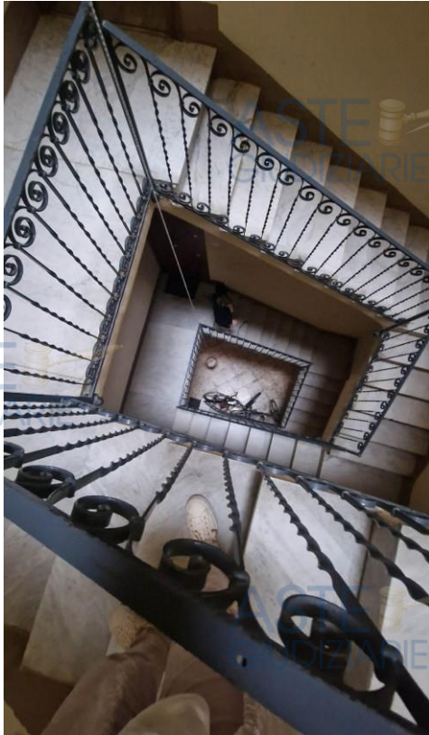
Foto 3. Vista dall'alto, della tromba della scala.
