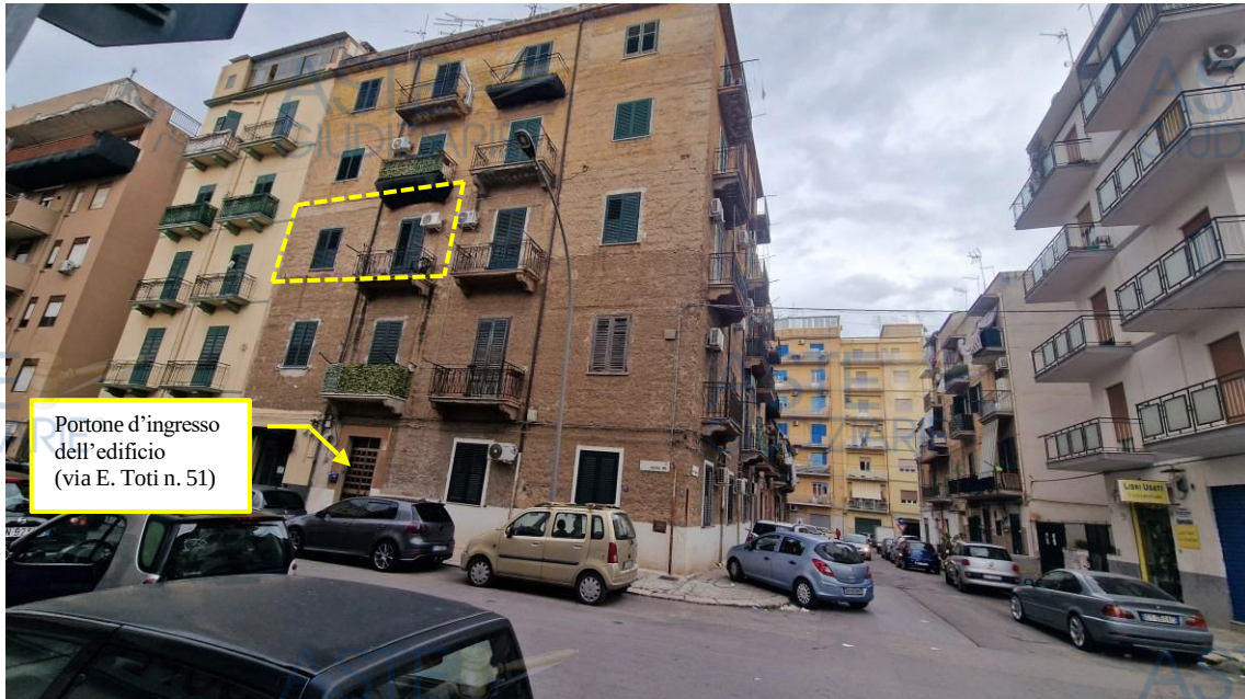
Foto 1. Vista d'angolo dell'edificio tra la via E. Toti e la via Morozzo della Rocca. In tratteggio, il bene pignorato.
