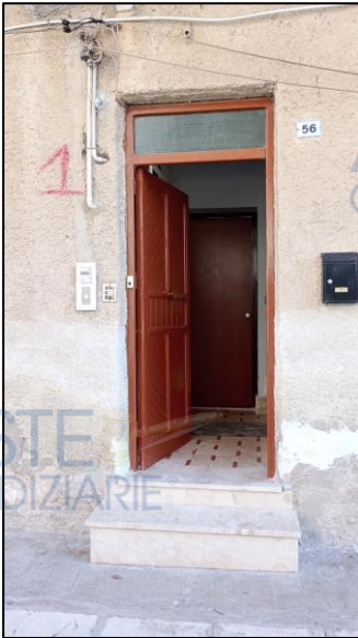
vista porta ingresso
