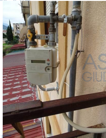
Contatore del gas.
