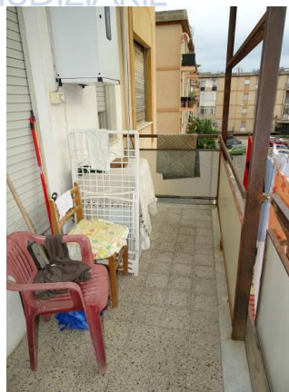
Balcone sul retroprospetto.
